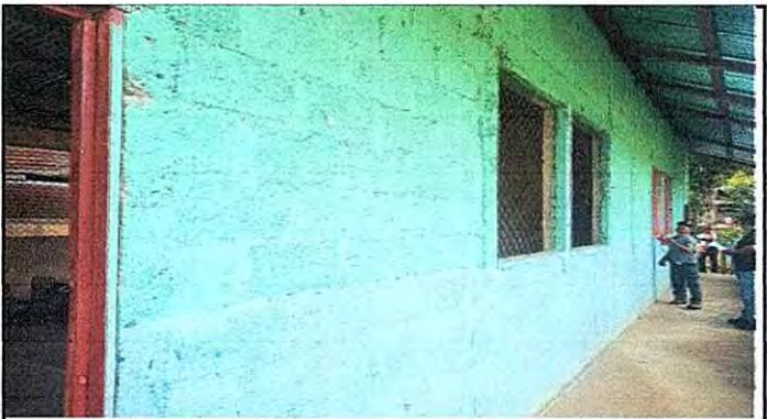
Foto 4: Aquí se muestra el estado de la pared de un módulo que necesita repello.
