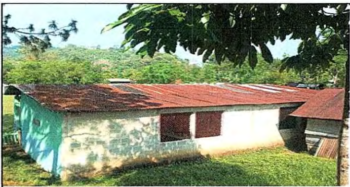
Foto 5: Aquí se muestra el deterioro de las láminas del segundo módulo en mal estado al igual la falta de repello.
